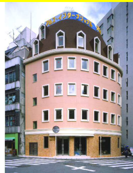
対象不動産 アムス第2ビル
